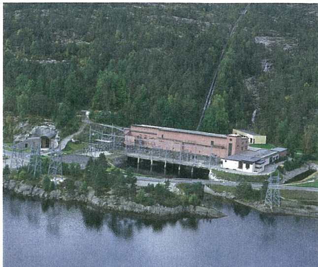
HØY PRIORITET: Mandalvassdraget i Vest-Agder har høy prioritet. Her kan 5-10 prosent av produksjonen gå tapt ved revisjon. Skjerka kraftverk i Åseral langt oppe i vassdraget har en årsproduksjon på 612 GWh. FOTO: AGDER ENERGI
