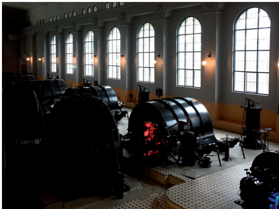
Gamle Vemork kraftstasjon.
